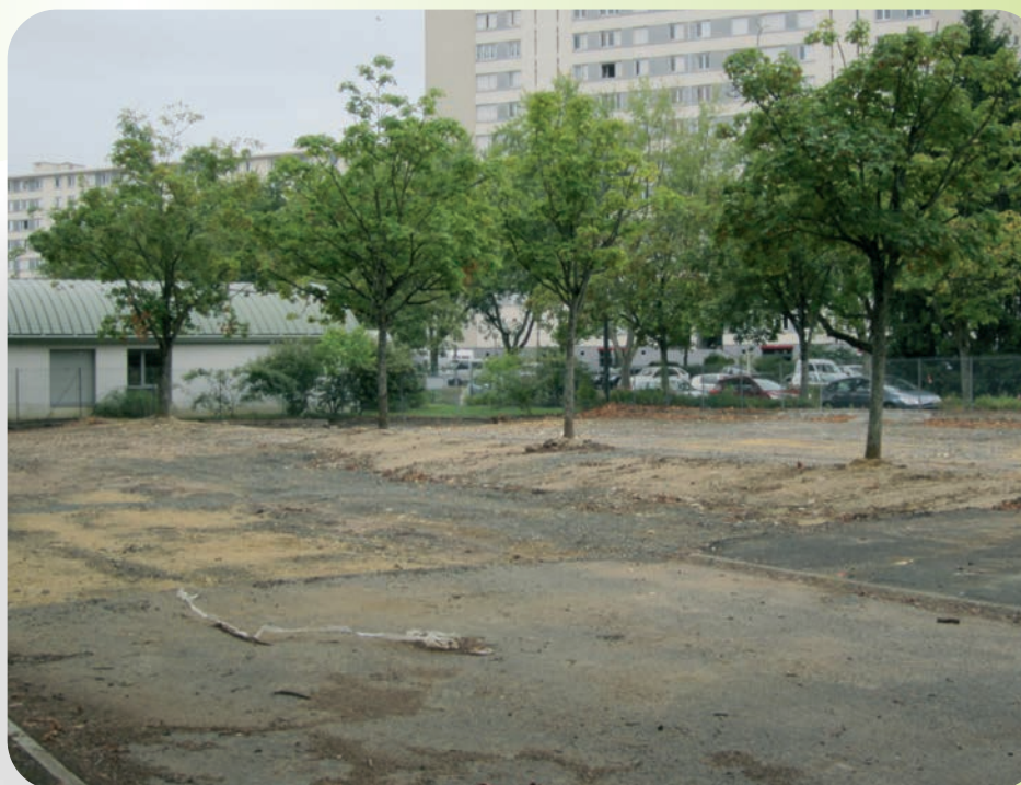
Le parking goudronné situé près de l'école a subi un dégroutage.
