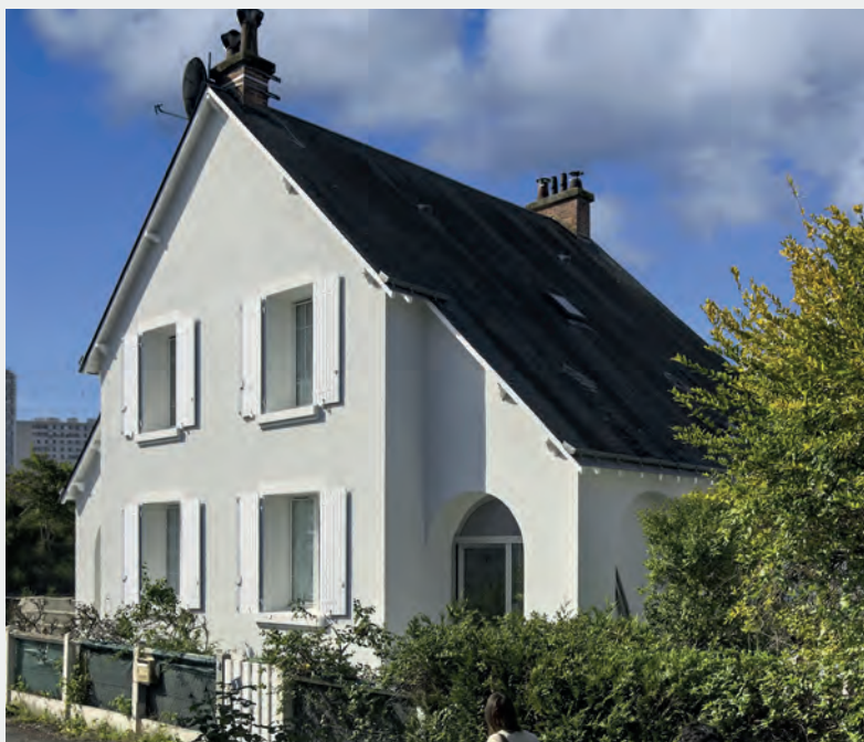
Résidence Beaujardin - TOURS Travaux de réhabilitation
