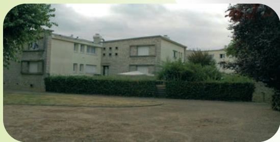
2 ème tranche de réaménagement avant le démarrage des travaux.
