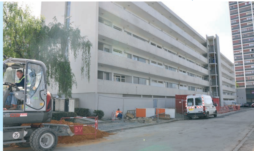
Travaux d'aménagement d'ascenseurs au SANITAS.
