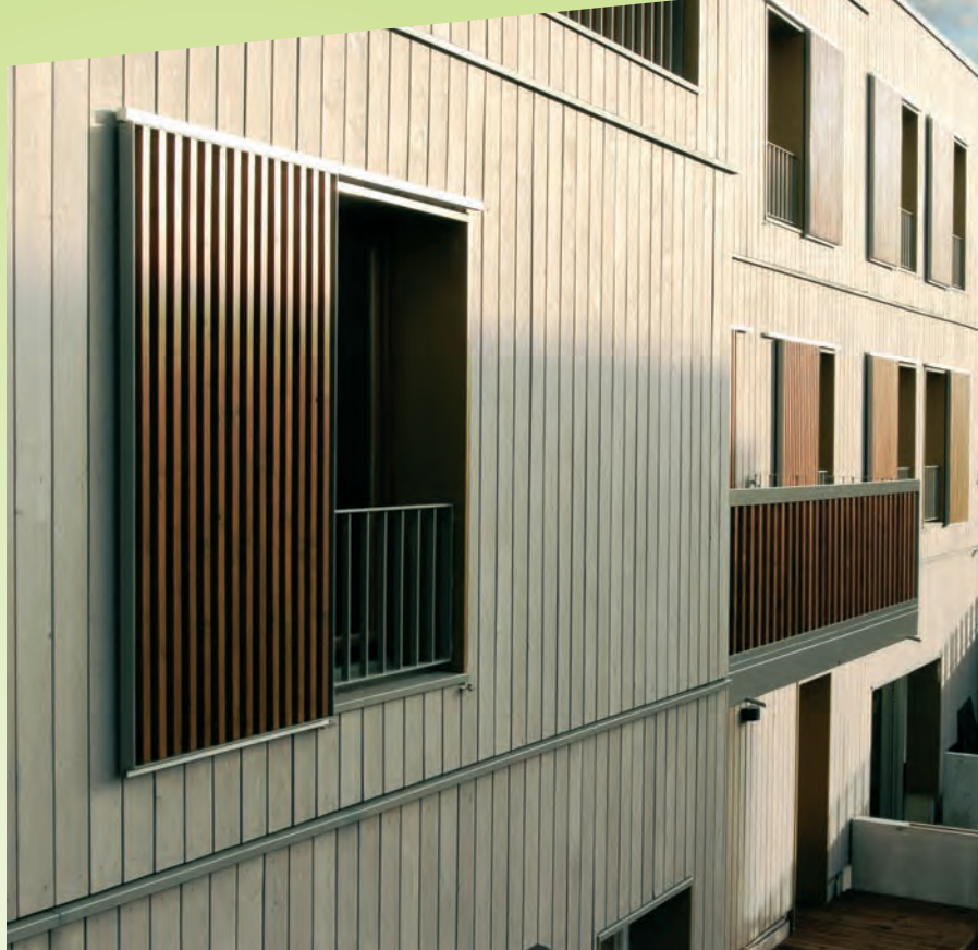
Résidence La Grenouillère 2 ème tranche (ossature bois).
