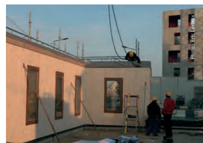
Montage des murs bois.
