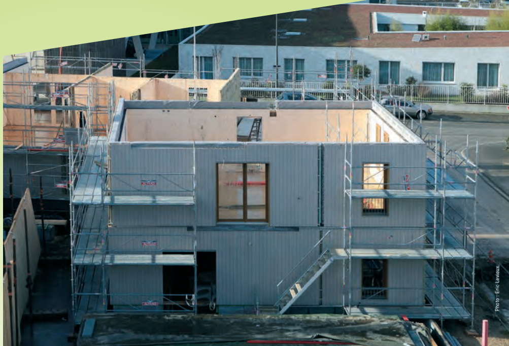
Chantier de la résidence La Grenouillère 2 ème tranche.
