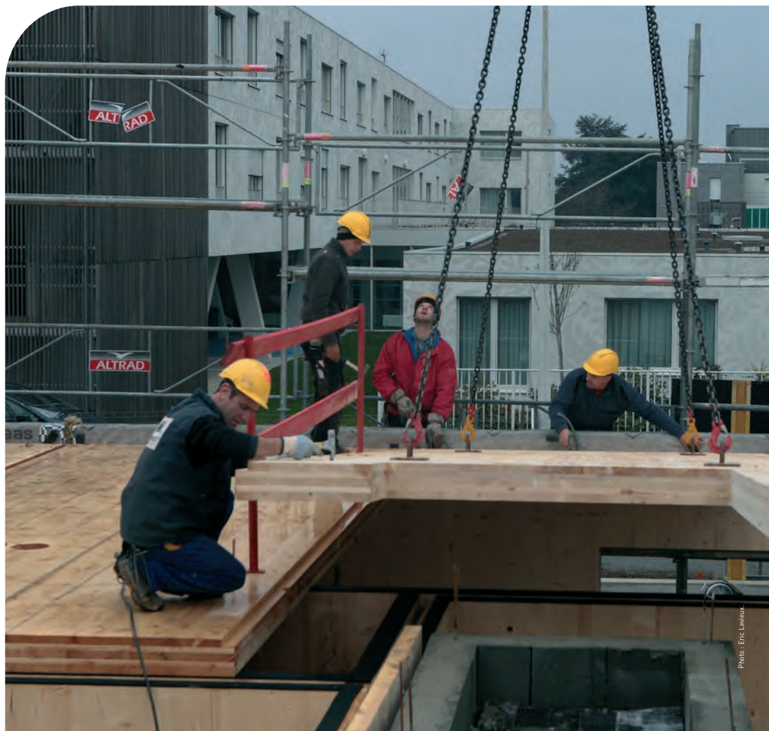
Chantier de la résidence La Grenouillère (2 ème tranche).
